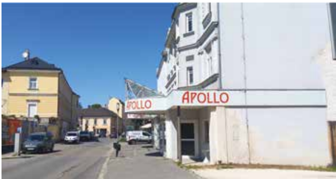
Foto 4 | Entrée Bahnhofsstraße. Foto: J. Fegyő
