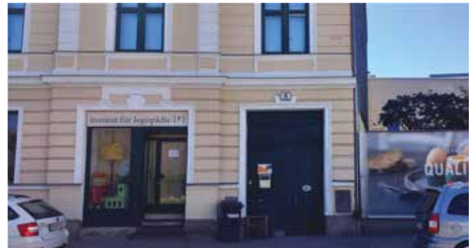
Foto 5 | Neugestaltung Fassade. Foto: J. Fegyő
